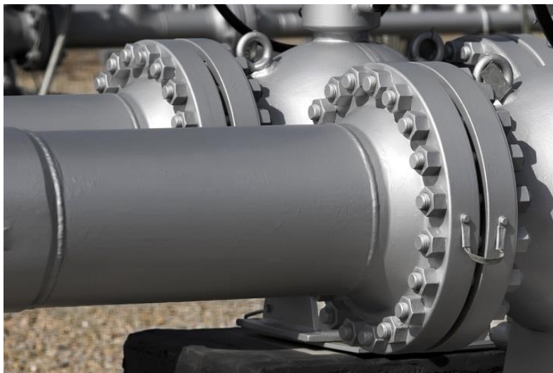
8.9. Prirubnički spoj na cevovodu, sa "kratkom" vezom-premošćenjem
