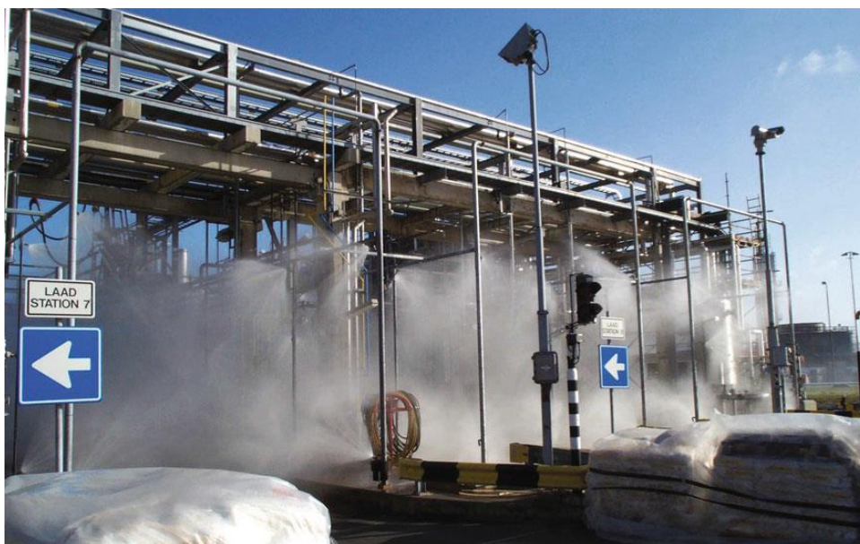
Slika 8.2. Sistem za zaštitu od požara
